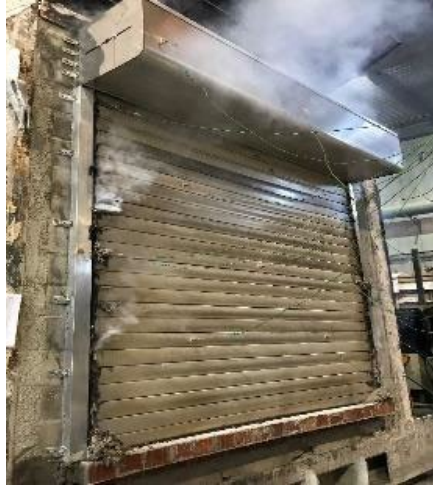
Protección contra incendios
